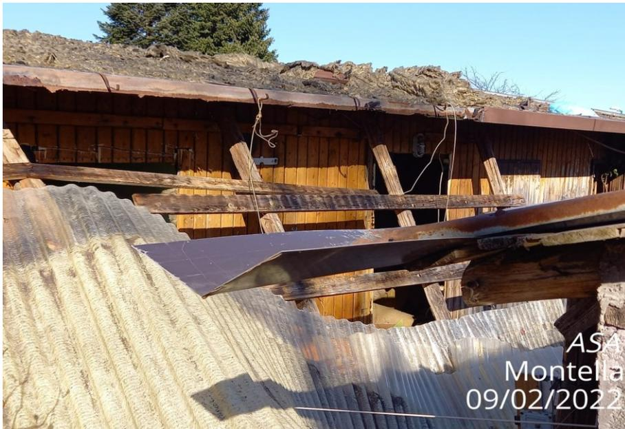
**Prefabbricato leggero con tetto ricoperto di lana di roccia e tettoia antistante completamente crollata. (A lato)**
