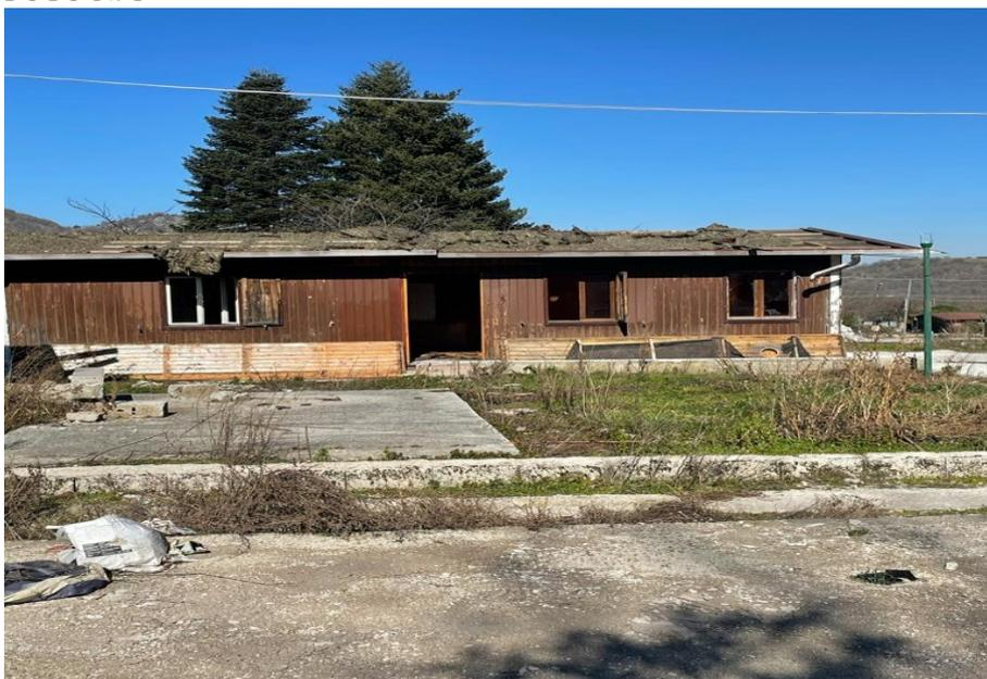
**Carcassa di un prefabbricato leggero con il tetto interamente ricoperto di lana di roccia, che in alcuni punti penzola da esso.**
