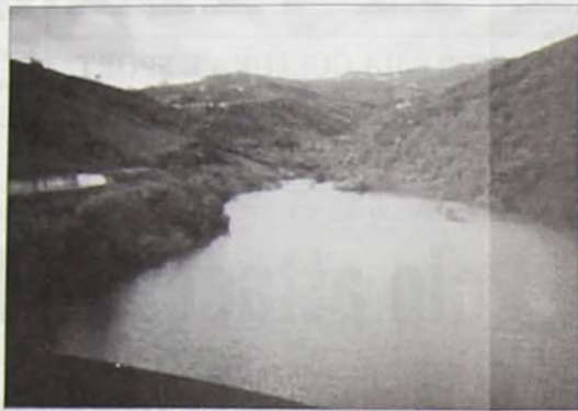
La diga Macchioni in territorio di Castelbaronia
