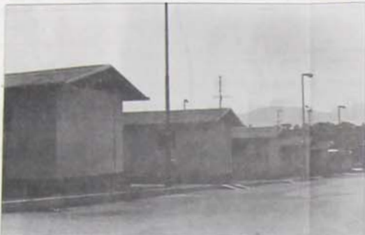
Avellino - I prefabbricati di campo Amati.
