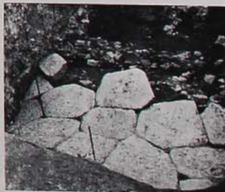
Un tratto di strada a Flumeri
