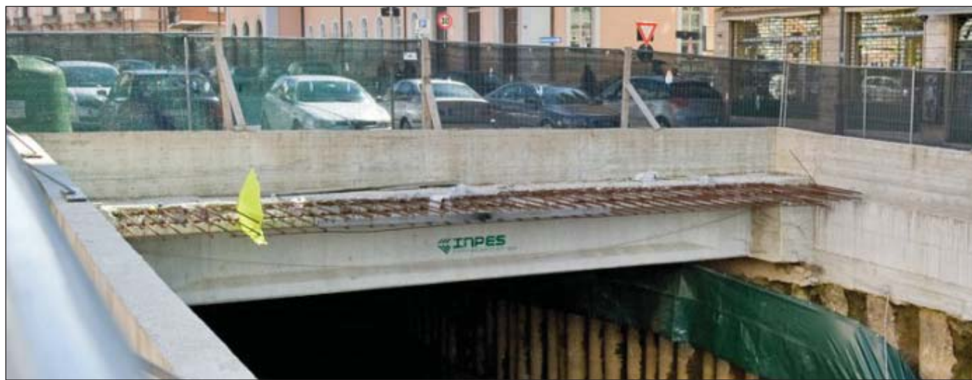
L'ingresso del tunnel da piazza Garibaldi (Foto di Carmine Bellabona)
