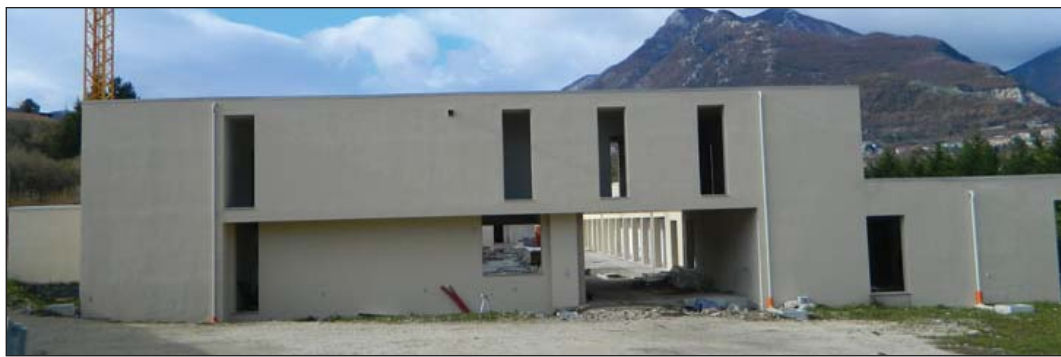
Lo stato dei lavori nel cantiere
