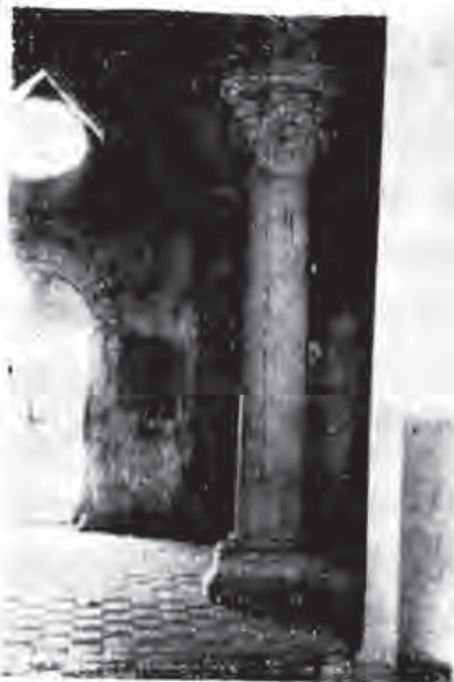
Cappella Superiore: Interno.
