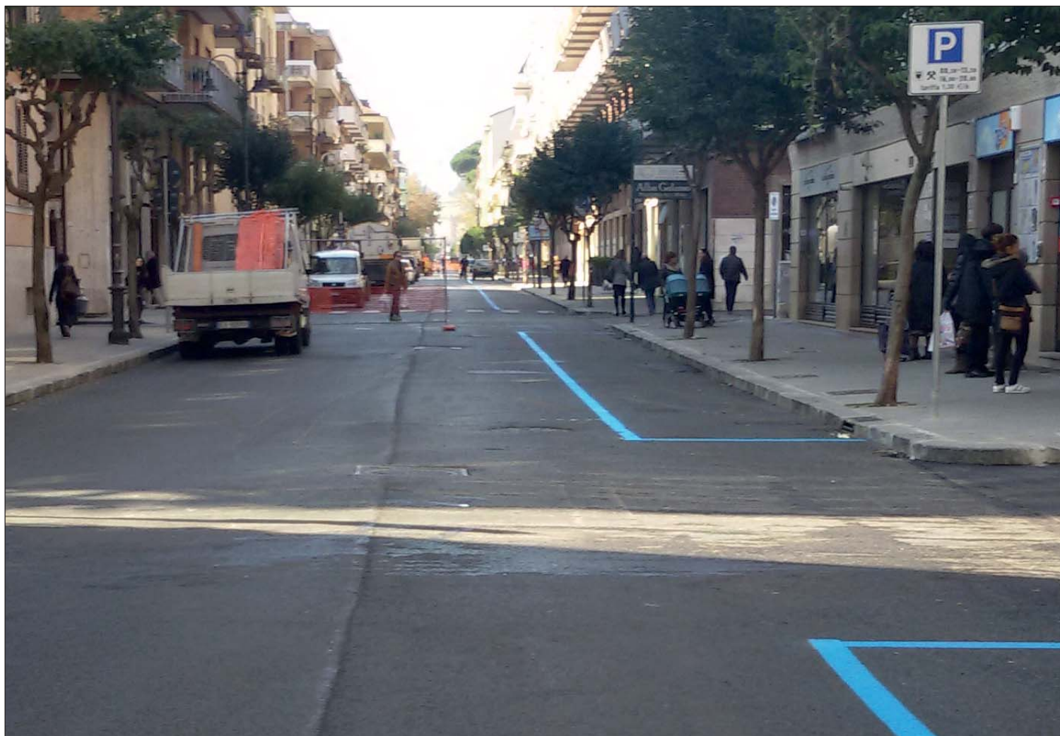
Il cantiere di Corso Europa
