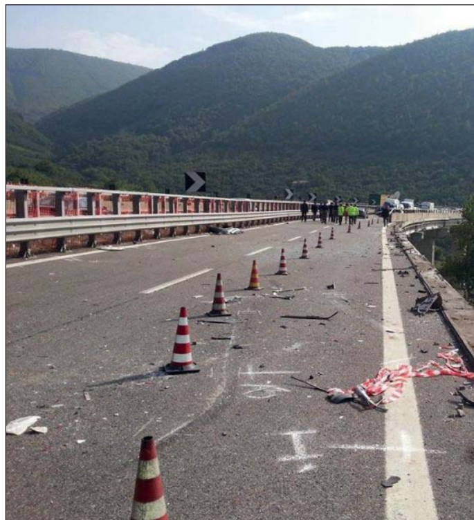
Il viadotto Acqualonga sull'A16
