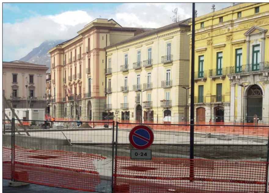
Il cantiere dal lato del Palazzo vescovile
