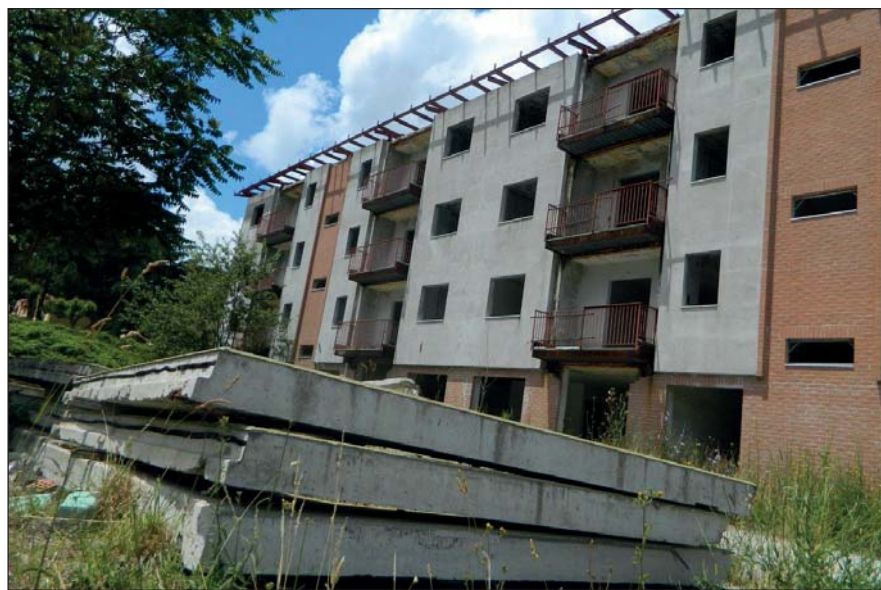
Lavori per la costruzione di case popolari
