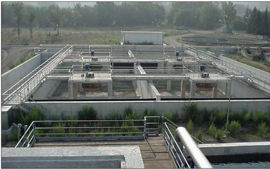
Un impianto di depurazione
