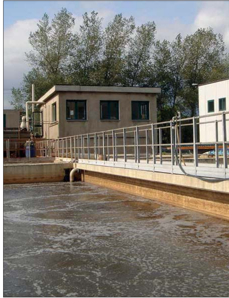
Un impianto di depurazione
