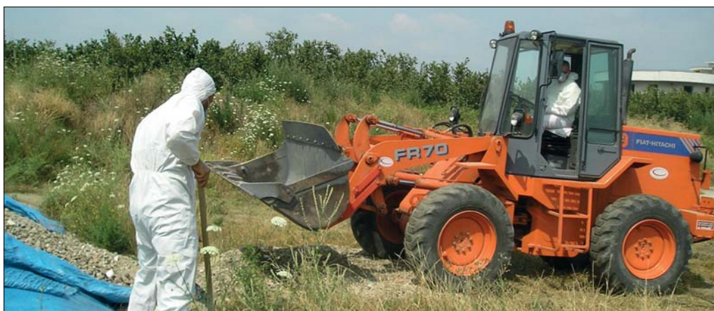
Lavori di bonifica
