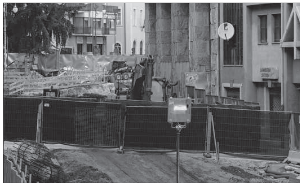
Un tratto del tunnel in costruzione (foto di Carmine Bellabona)
