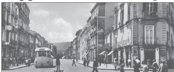
Corso Vittorio Emanuele con la filovia in primo piano in una foto degli anni '60
