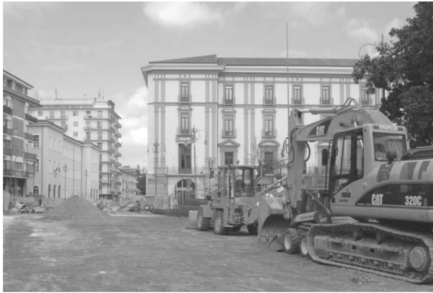
Il cantiere dei lavori a Piazza Libertà
