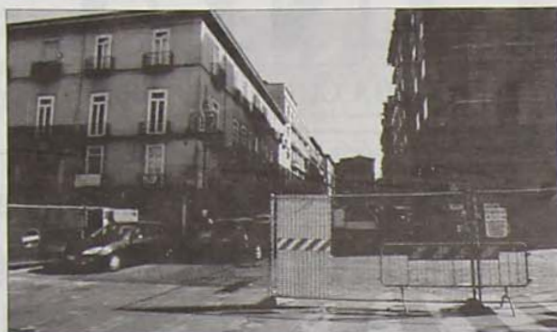
Il cantiere di Corso Vittorio Emanuele (foto di Carmine Bellabona)
