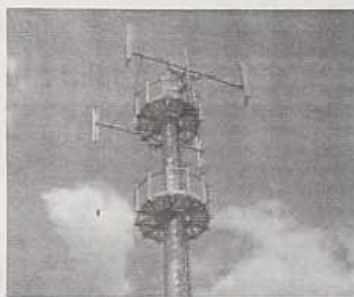
Un'antenna di telefonia mobile
